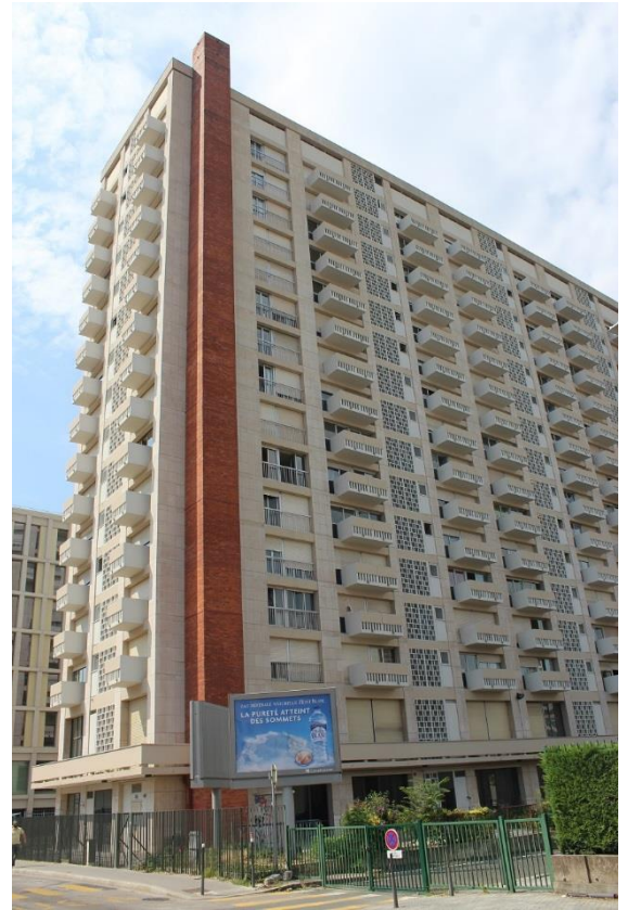
Figure 2 : la barre Desaix, rue des Cuirassiers, après sa réhabilitation
